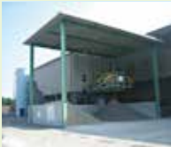
脱塩・脱水処理施設
