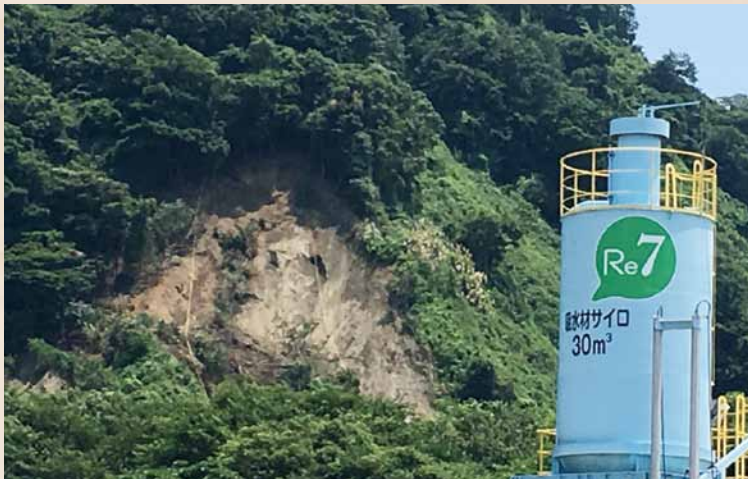
リライフ前国道 188 線・J R山陽線土砂崩れ
