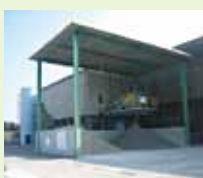
脱塩・脱水処理施設
